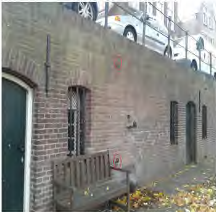
Figuur 4: Voorbeeldfoto positie prisma's (rood omcirkeld)
